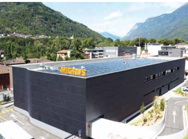
Migros Bellinzona: la facciata fotovoltaica permette di sfruttare al meglio l'irraggiamento invernale.
